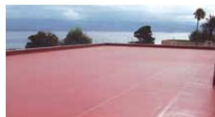
Visualisation d'un Système d'Étanchéité Liquide **MARISEAL®** avec entoilage total et Finition colorée **MARISEAL® 420**.
