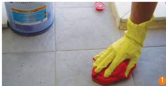
La totalité de la surface doit être activée avec MARITRANS® PRIMER. Utiliser un chiffon propre pour appliquer le produit.
